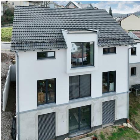
Bei diesem Bauvorhaben liefen Planung und Statik direkt über uns. Auf dem Keller folgt der Holzbau als Staffelgeschoss mit 200 m<sup>2</sup> Wohnfläche. Überall wurden Massivholzdecken verbaut, die erstklassigen Schalldämmwert bieten. Die Wärmedämmung für Wände und Dach wurde mit Zellulose und Holzfasern ausgeführt.
