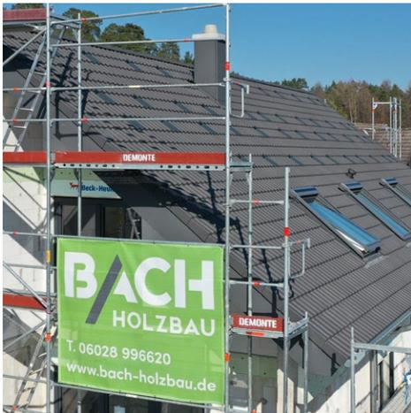
Hier haben wir die klassische Zimmererarbeit eines Dachstuhls mit Wärmedämmung und Eindeckung ausgeführt.
